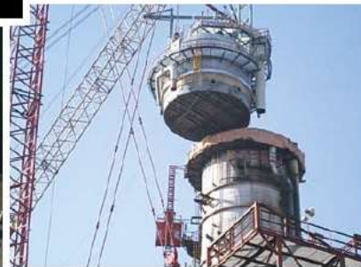
2004 Aufbau von Trennkolonnen in Indien.
